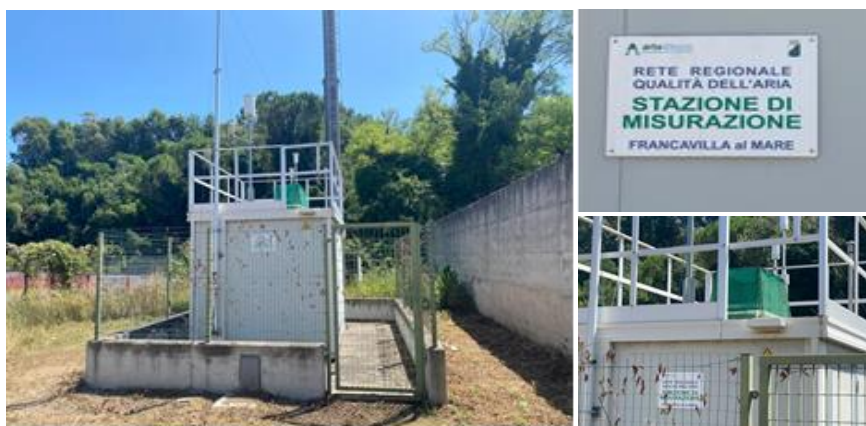
Figura 6. Stazione 2 di biorilevamento predisposte per la campagna 2025 di biomonitoraggio dell'ozono troposferico individuato nell'ambito della rete di rilevamento della qualità dell'aria della Regione Abruzzo: Francavilla al Mare (CH).
